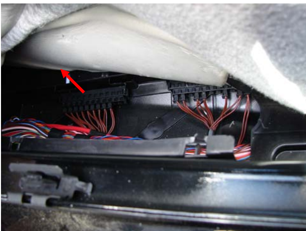
Bild 5: Kabelkanal geöffnet, CAN-Verteiler
