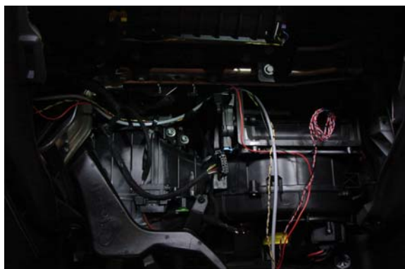
Bild 14: Kabelführung hinter dem Handschuhfach
