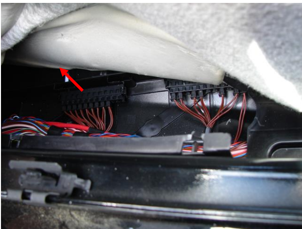
Bild 5: Kabelkanal geöffnet, CAN-Verteiler
