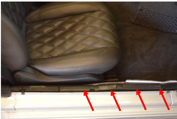
Bild 3: Kabelkanal öffnen (rote Pfeile)
